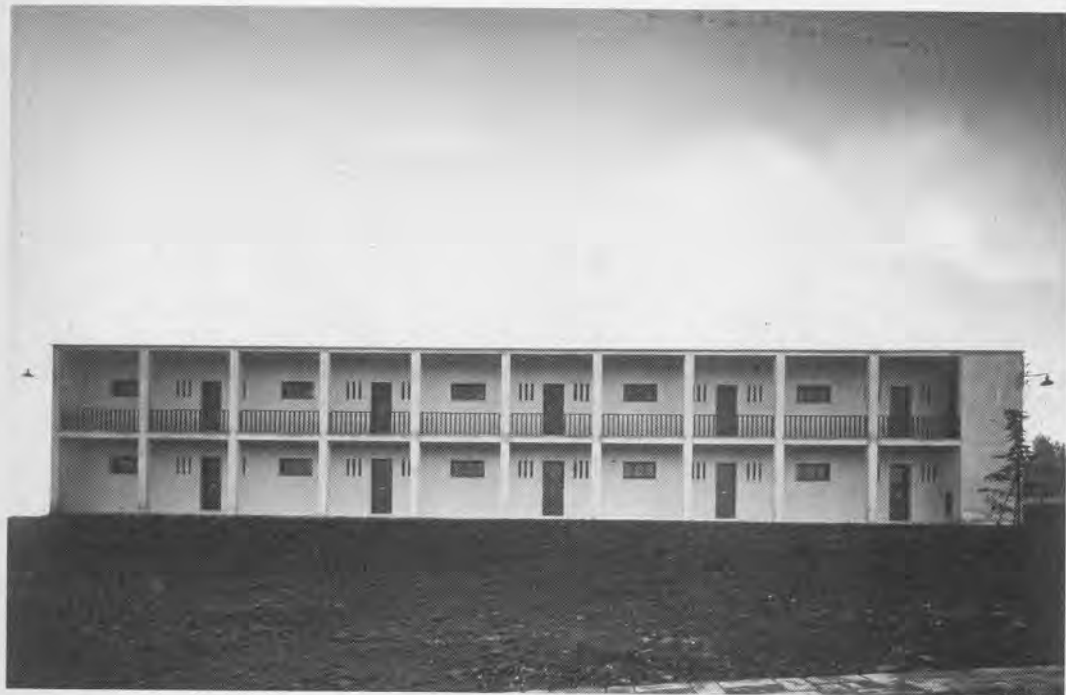
7/ Roma, Tiburtino III, veduta di uno degli edifici a ballatoio.
