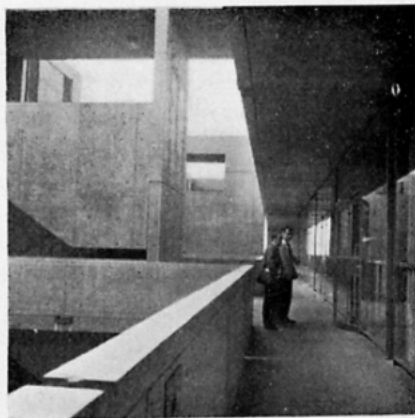
Fig. 6 - Il ballatoio di accesso ai laboratori
