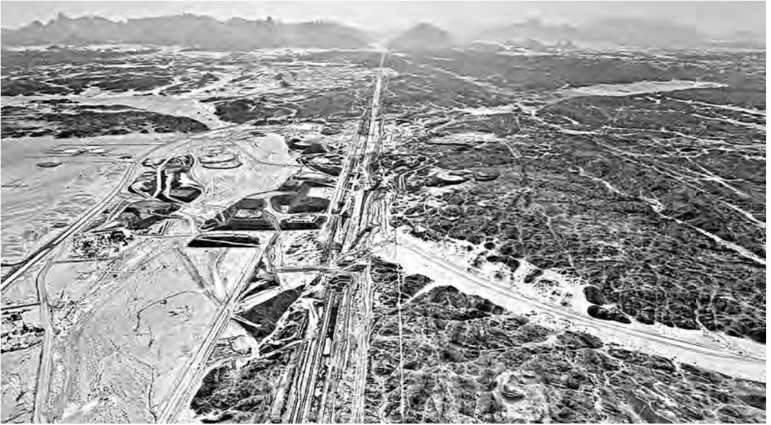
↑ Vista aerea di The Line in costruzione. Foto Giles Pendleton, 2024.
