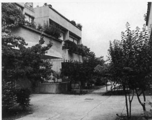
6/Urbino, Magistero. Una delle aule sospesa alle travi di copertura.
