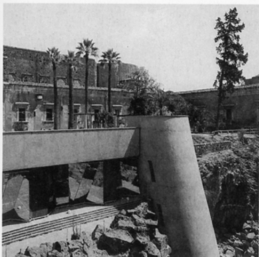
26/Catania, Recupero del convento dei Benedettini. Prospetto sud, la scala inclinata.
