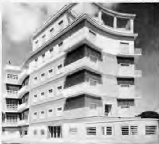
L/U, Luccichenti, Palazzina in via Panama, Roma, 1936.
