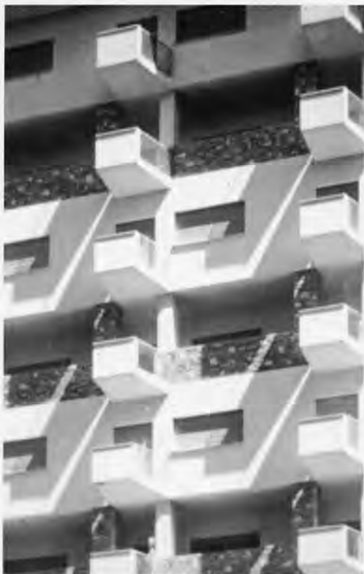
4/U. Luccichenti, Edificio intensivo Società Generale Immobiliare in viale Pinturicchio, Roma, 1949-'50.
