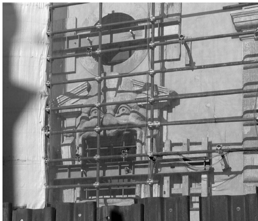
1. Dettaglio del prospetto della Bibliotheca Hertziana durante i lavori di ampliamento.
