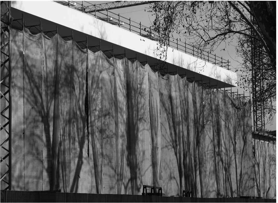
2. Museo dell'Ara Pacis in cantiere.
