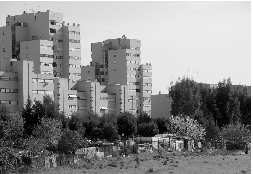
3. Abitazioni a Torvecchia. Contrasti.
