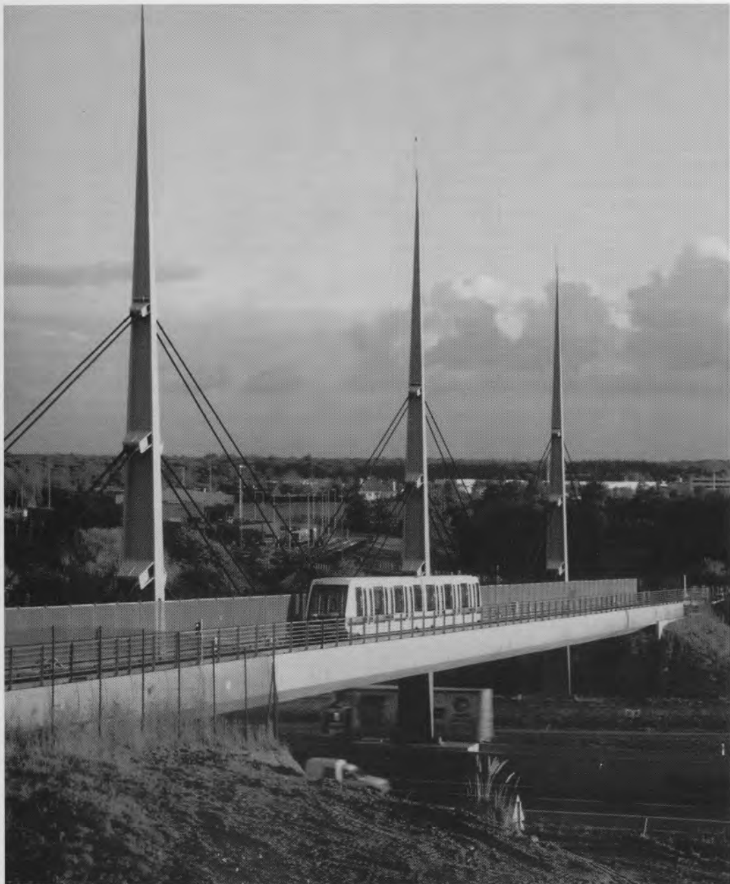
13/ N. Foster, Viadotto Le Val, Rennes (1998). Veduta d'insieme.
