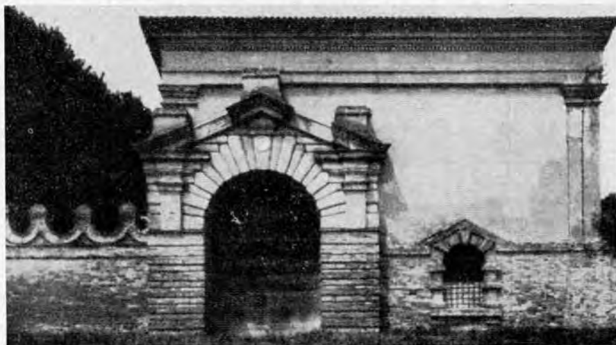
fig. 8 Pontecasale (Padova), portale e barchessa della villa Garzoni
