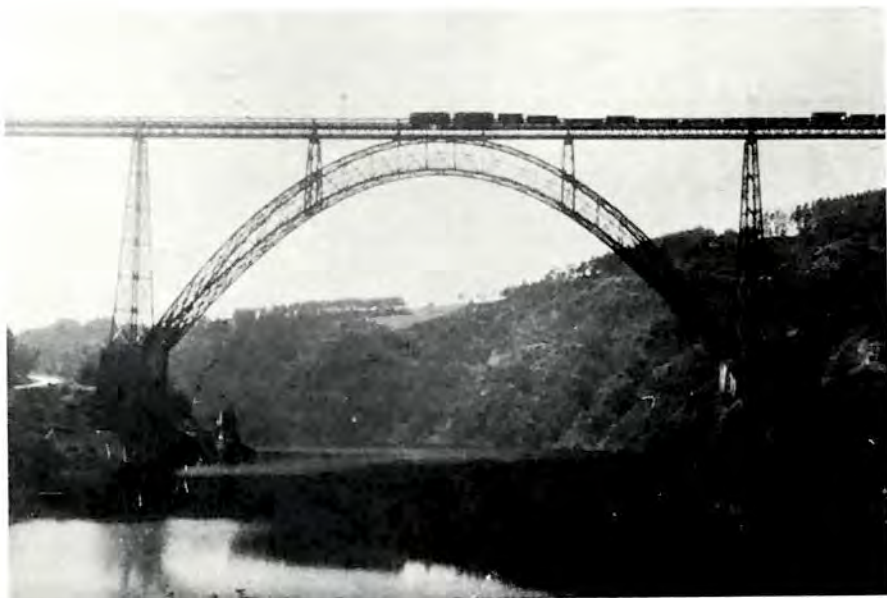
fig. 18 Eiffel - Viadotto di Garabit 1880.
