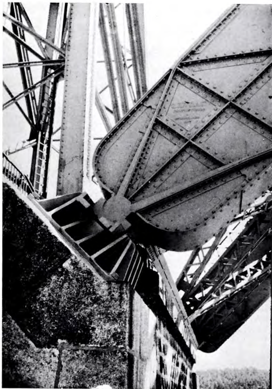
fig. 22 Eiffel - Ponte Maria Pia a Porto 1876, particolare della cerniera.
