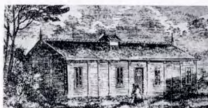
fig. 8 Padiglione prefabbricato in ferro a Bal- moral Castle 1851.
