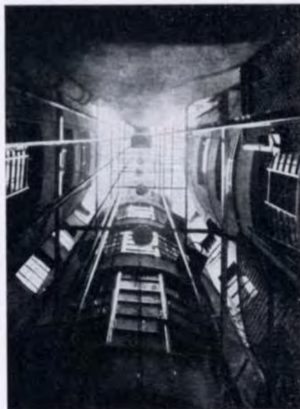
Fig. 3 Palazzina Nebbiosi. Veduta di un cortile interno.
