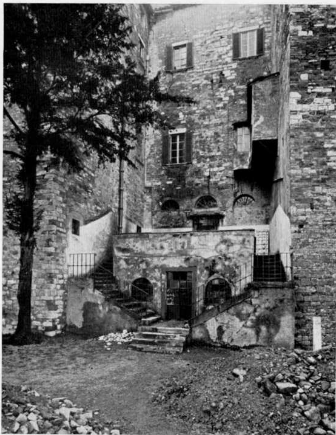
Perugia: Facoltà di Magistero: veduta del prospetto nord del fabbricato prima del restauro. I tre archi del fondo sono stati riaperti; il corpo del fabbricato basso è stato demolito e al suo posto è stata costruita una delle due aule superiori.
