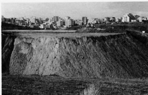
2/ Roma: Castel Giubileo. Movimenti di terra per l'insediamento (nel paesaggio) di un nuovo quartiere di edilizia residenziale pubblica.
