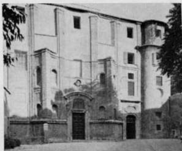
Fig. 8 - Facciata di Santa Maria dei Sette Dolori.
