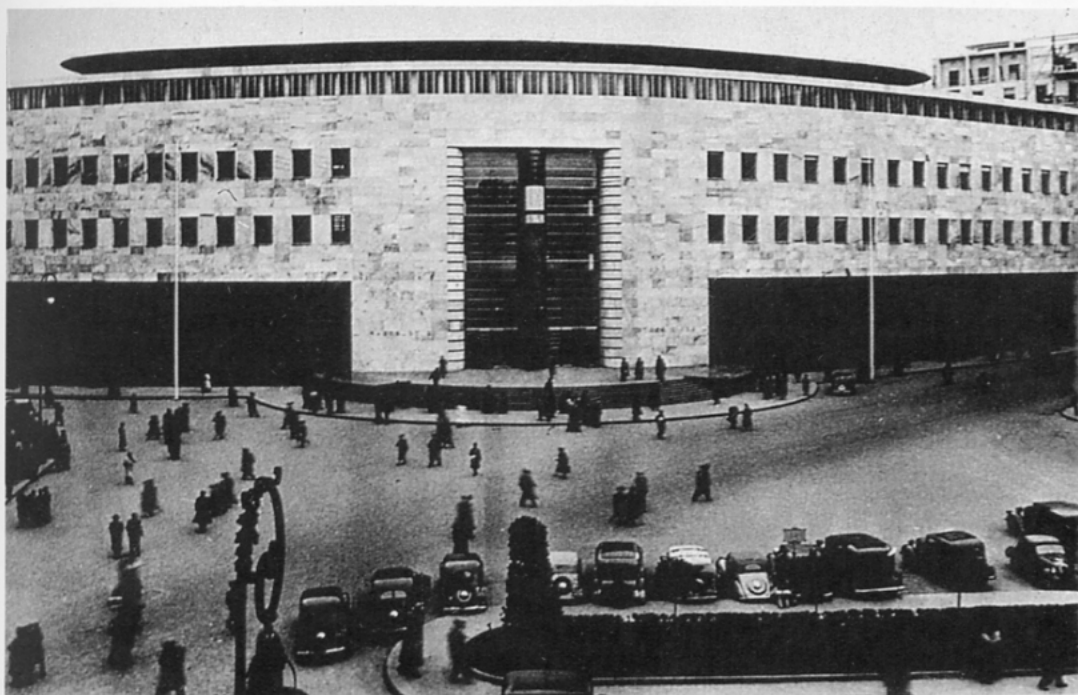
9/Veduta dell'edificio ultimato.
