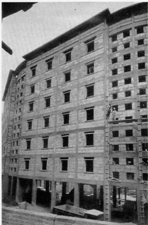
1/Case popolari in via di Donna Olimpia a Roma. Costruite con ossatura di cemento armato, hanno tamponature e solai realizzati con blocchi e pignatte di calcestruzzo leggero di pomice.
